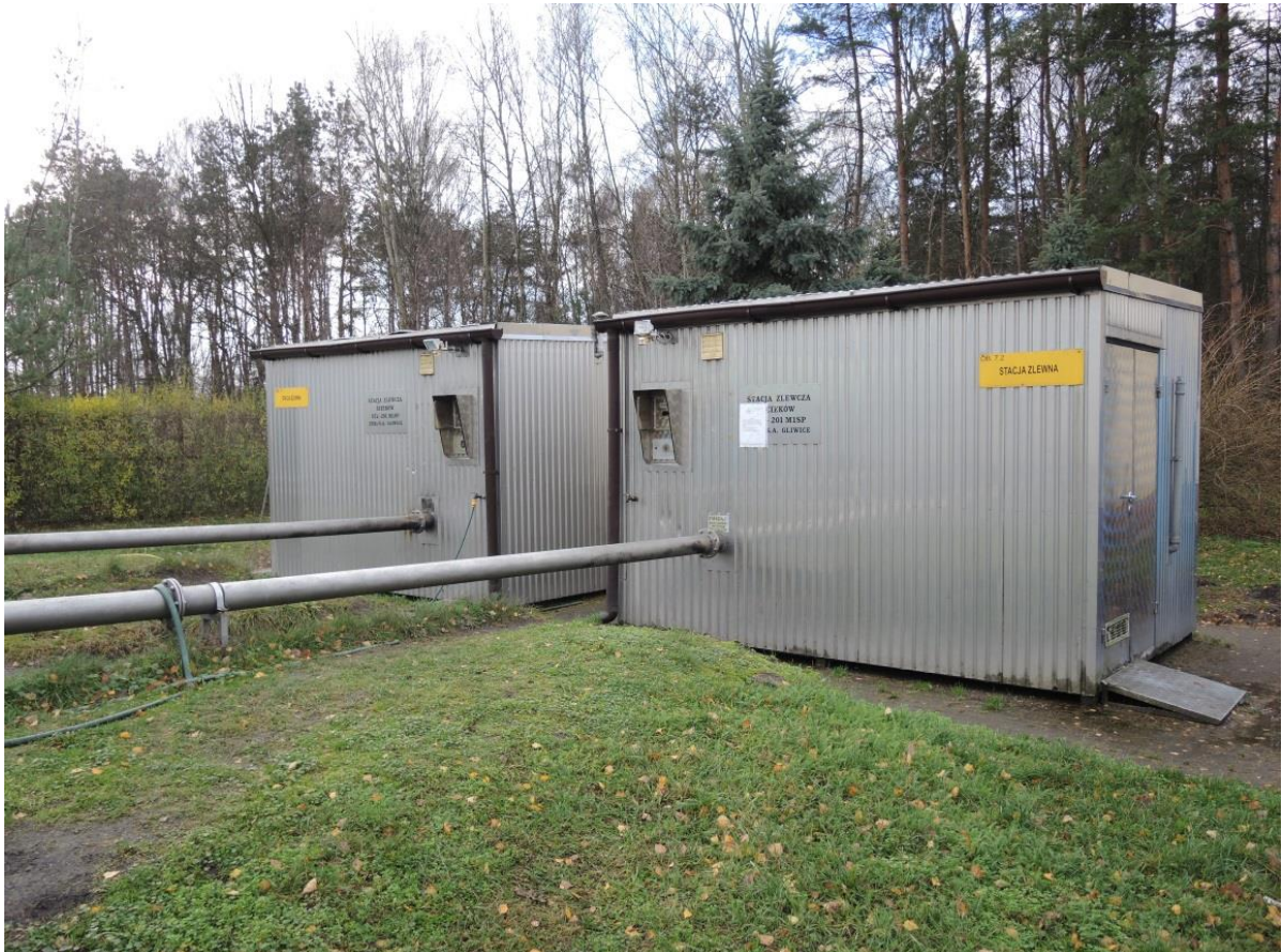
Fot. nr 3 Stacje zlewne ścieków dowożonych
