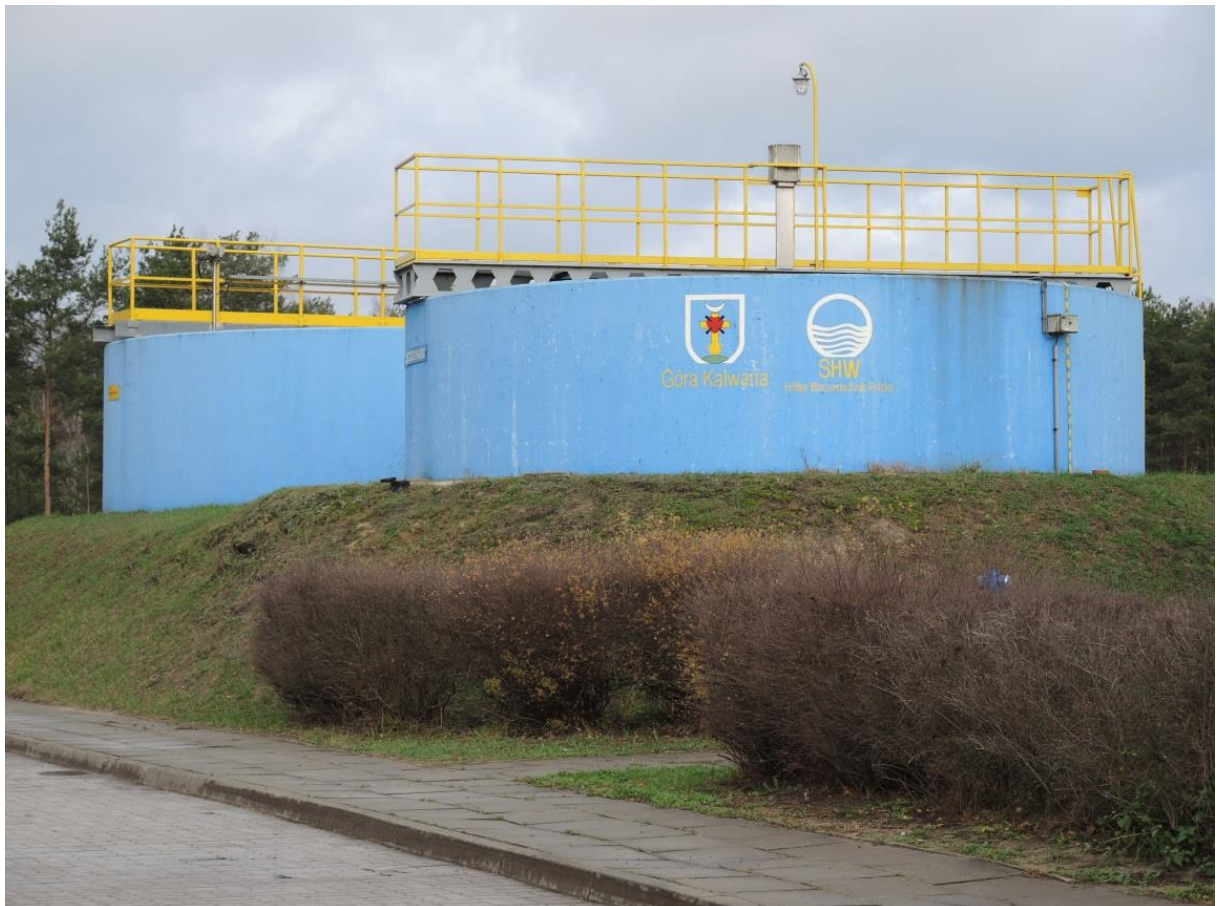
Fot. nr 10 Zagęszczacze osadu
