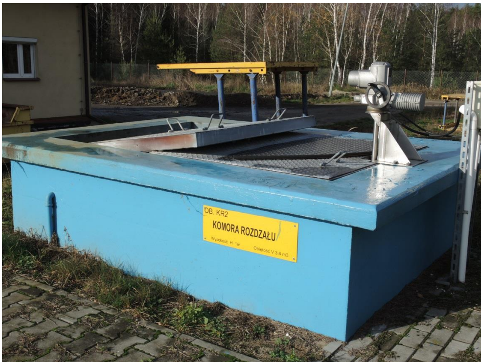
Fot. nr 5 Komora rozdziału
