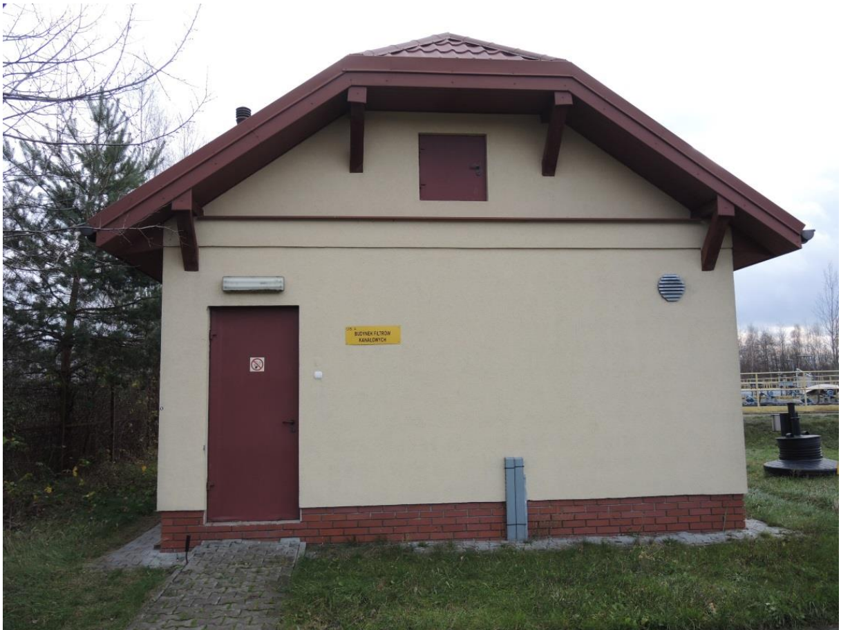
Fot. nr 8 Budynek filtrów kanałowych
