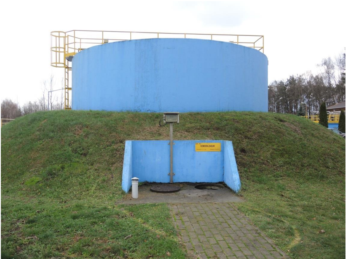
Fot. nr 11 Zagęszczacz osadu
