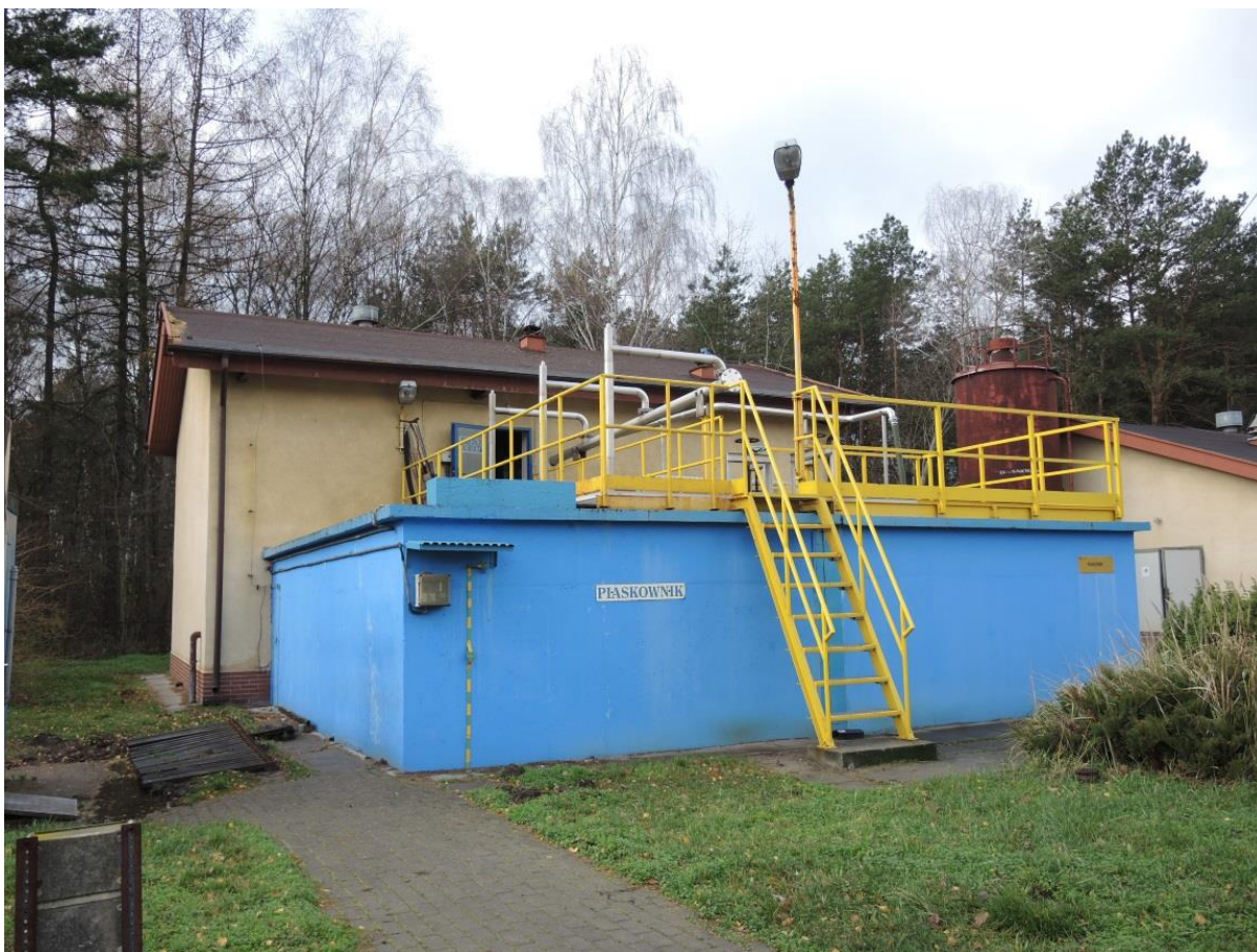
Fot. nr 2 Piaskownik napowietrzany
