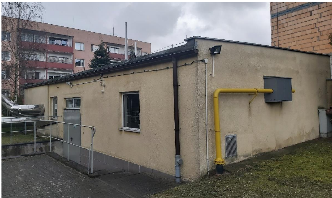
Rysunek 4. Budynek kotłowni 727 na dz. nr 506/15 (źródło: materiały własne)
