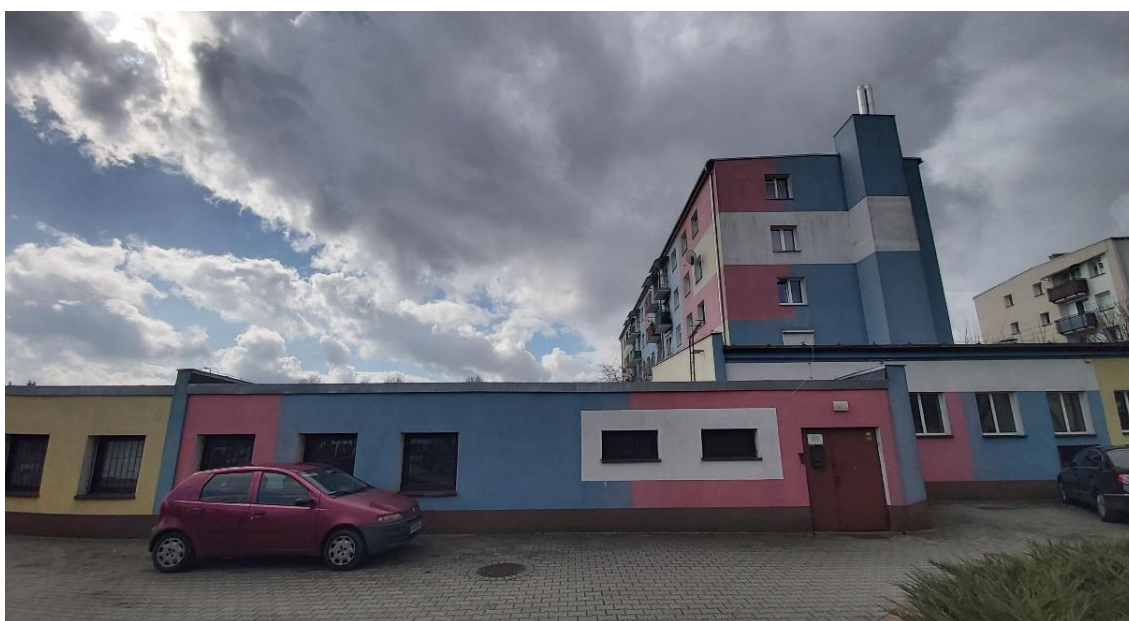
Rysunek 3. Budynek kotłowni przy ul. Chopina 20 (źródło: materiały własne)
