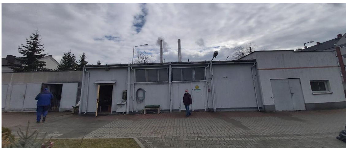
Rysunek 9. Budynek kotłowni Tropicco (źródło: materiały własne)
