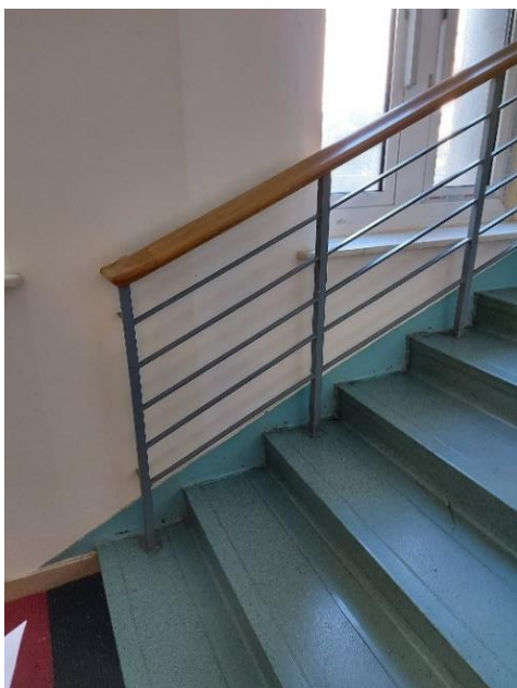
Zdjęcie nr 6. Schody w klatce schodowej
