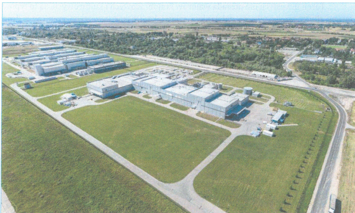
Rysunek 23 Widok na zabudowania przemysłowe w sąsiedztwie planowanej inwestycji.
