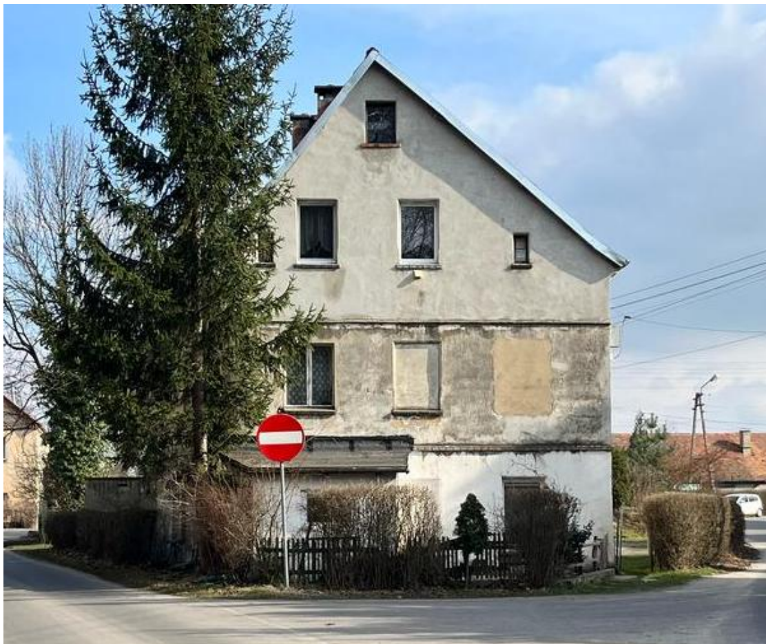
Zdjęcie nr 1 Elewacja zachodnia
