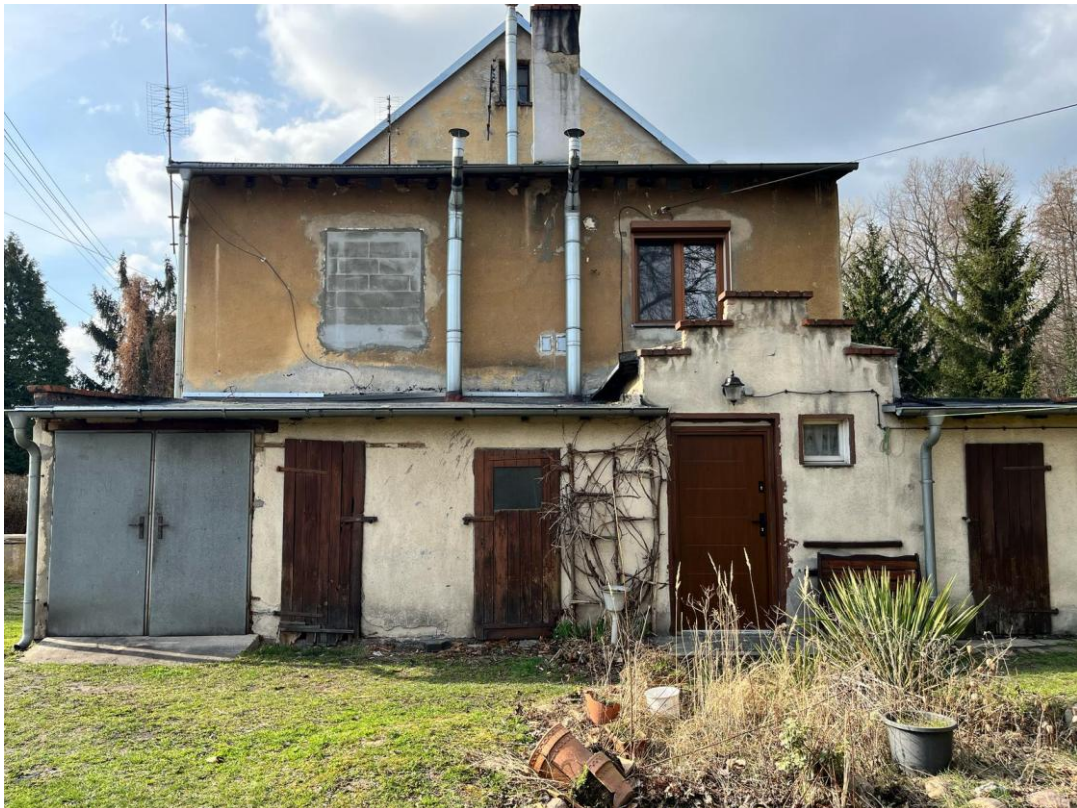
Zdjęcie nr 3 Elewacja wschodnia
