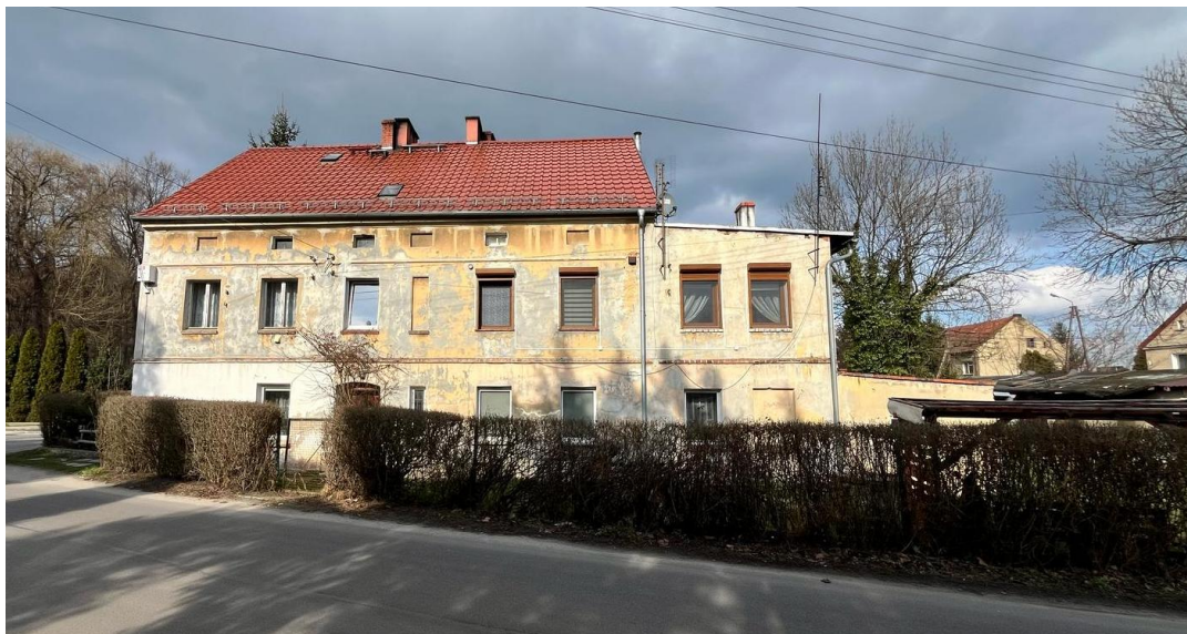
Zdjęcie nr 4 Elewacja południowa
