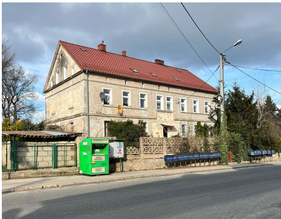
Zdjęcie nr 1 Elewacja południowa i zachodnia
