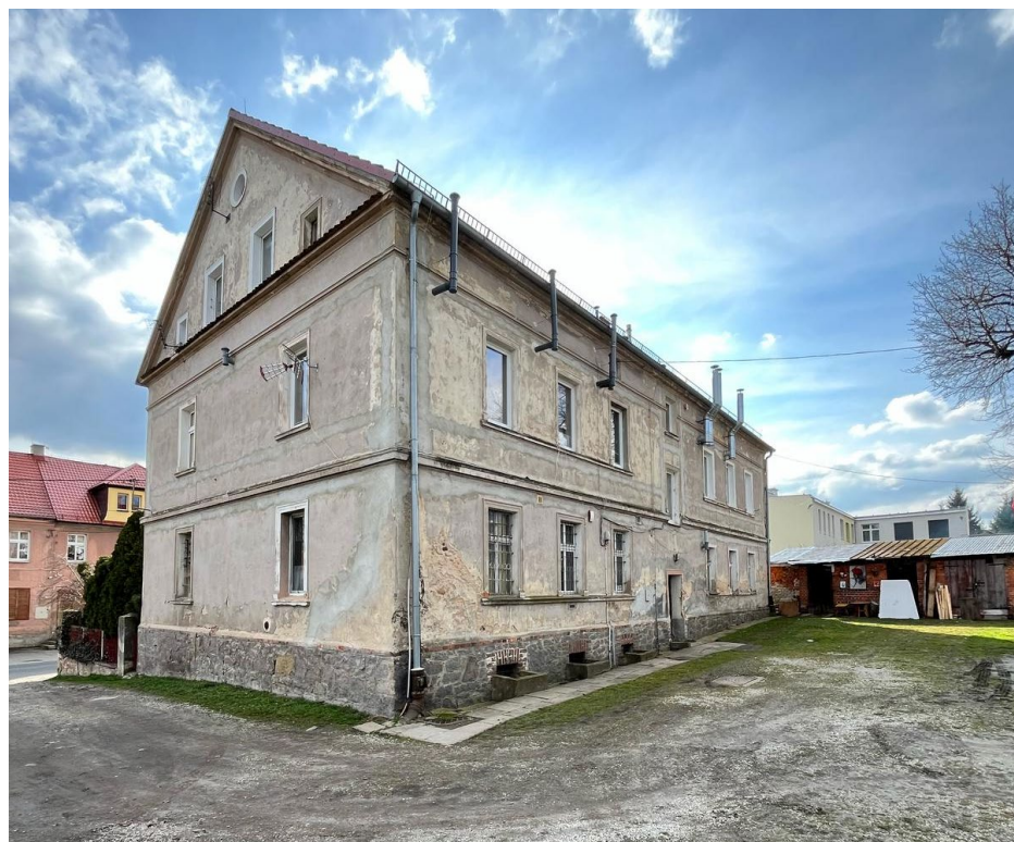
Zdjęcie nr 2 Elewacja północna i wschodnia
