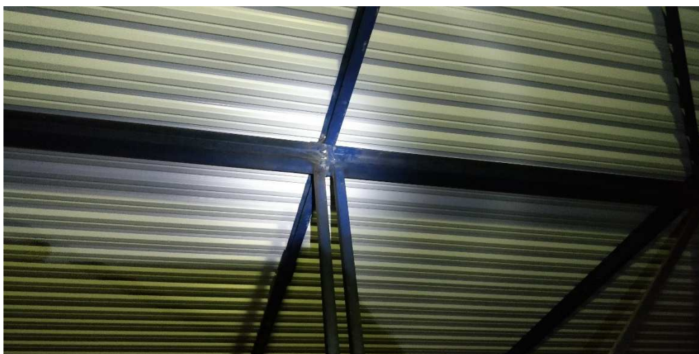
Fot.5 Połączenie pasa górnego kratownicy
