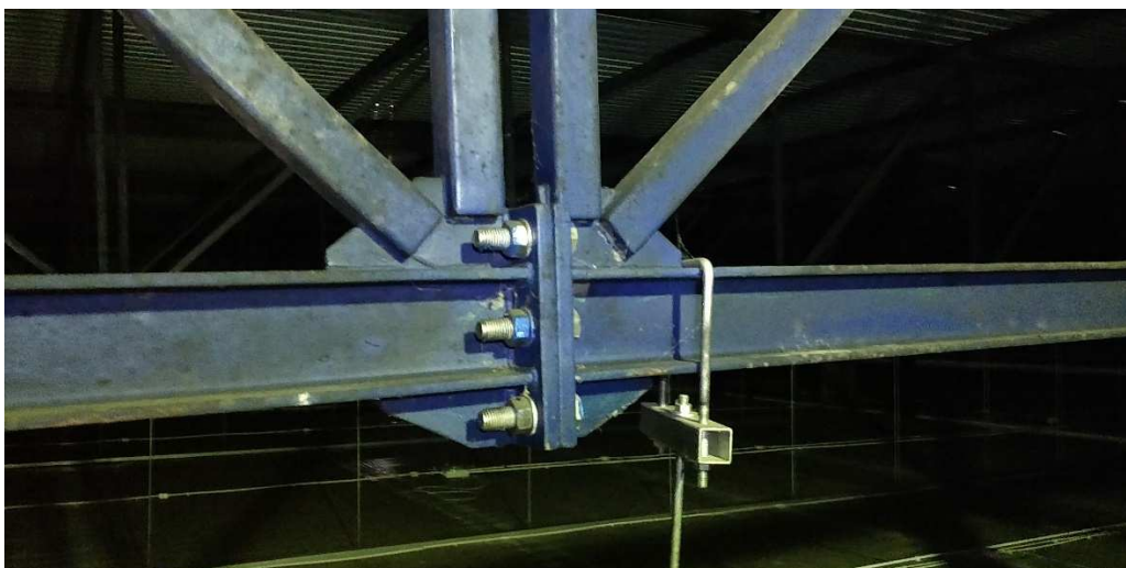
Fot.5 Połączenie pasa dolnego kratownicy
