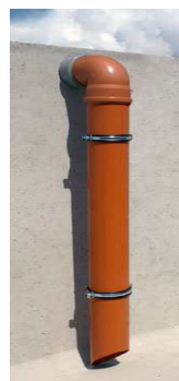
Rysunek 2 Przykładowe położenie końcówki przewodu przyłącza do opróżniania szamba.
