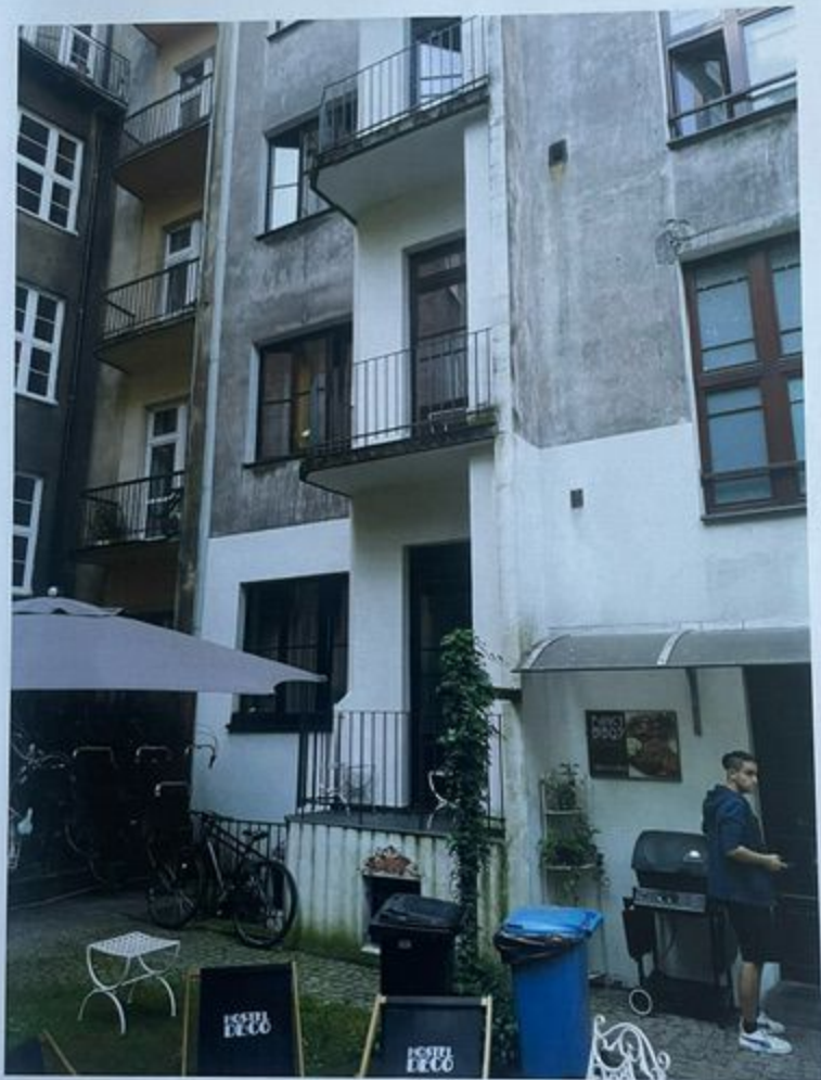
Fot 3 kamienica przy ul. Mazowieckiej 3a w Krakowie. Elewacja tylna. Lewa strona parteru.
