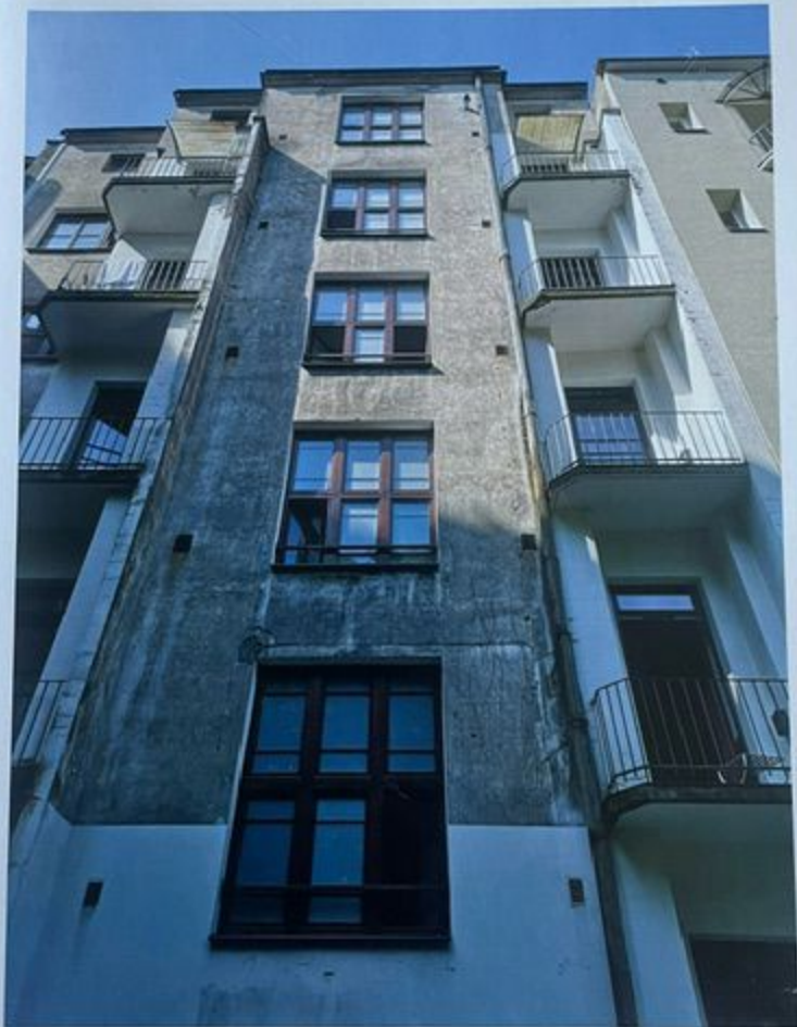
Fot. 2 kamienica przy ul. Mazowieckiej 3a w Krakowie. Elewacja tylna. Prawa strona elewacji.
