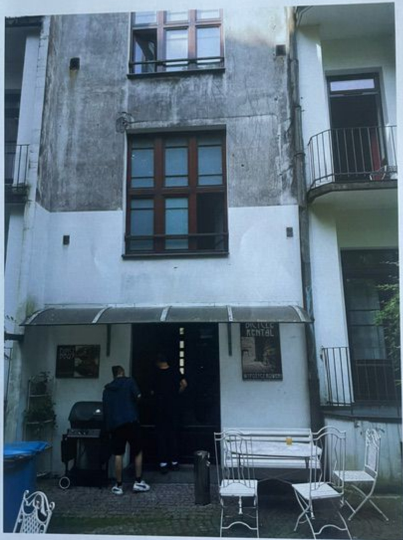
Fot 4 kamienica przy ul. Mazowieckiej 3a w Krakowie. Elewacja tylna. Prawa strona parteru.
