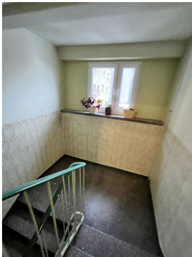
Zdjęcie nr 5 Klatka schodowa - spocznik
