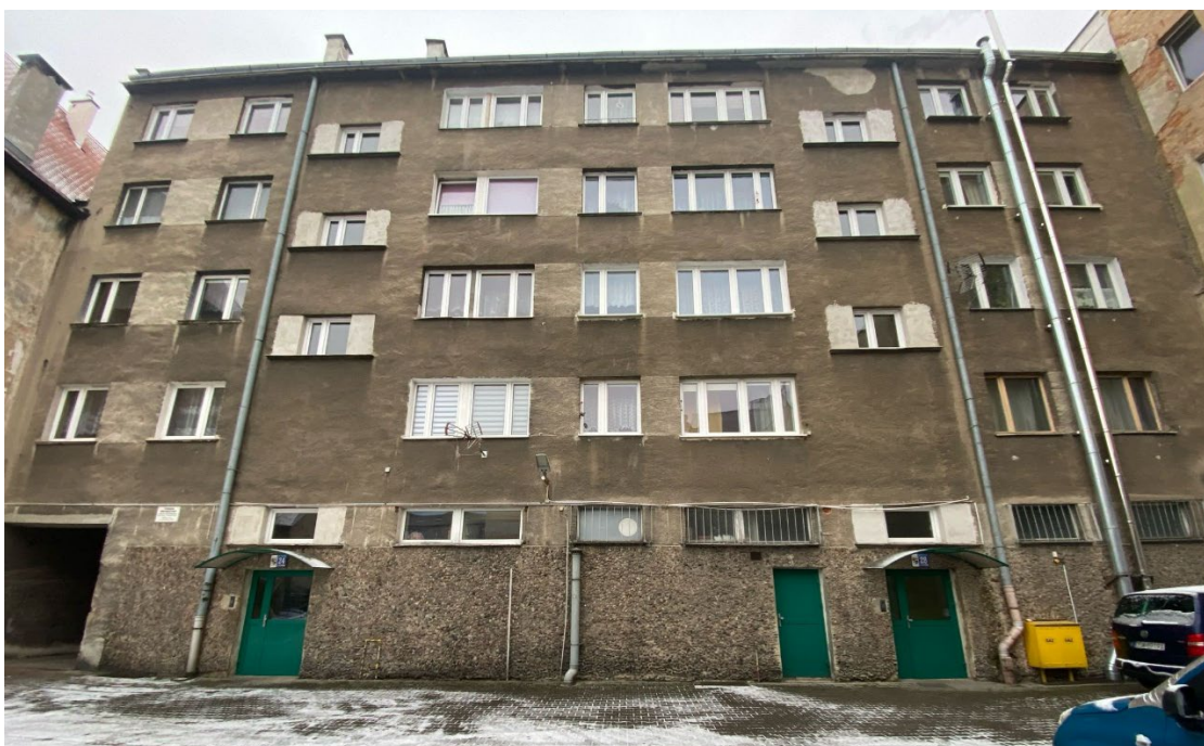
Zdjęcie nr 2 Elewacja północno-wschodnia
