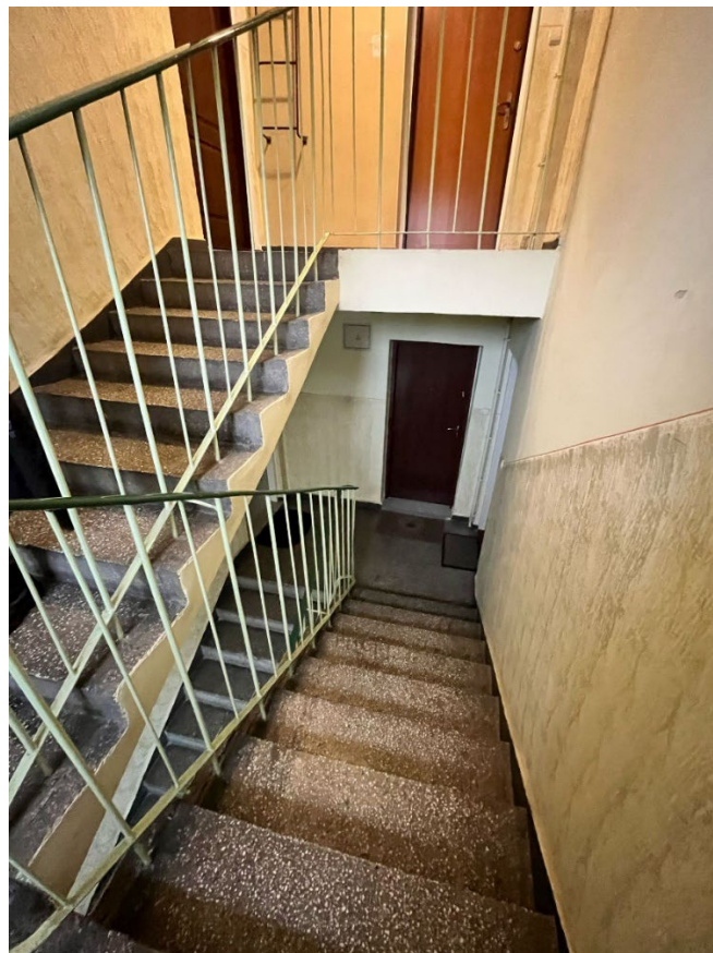
Zdjęcie nr 4 Klatka schodowa – 5 kondygnacja
