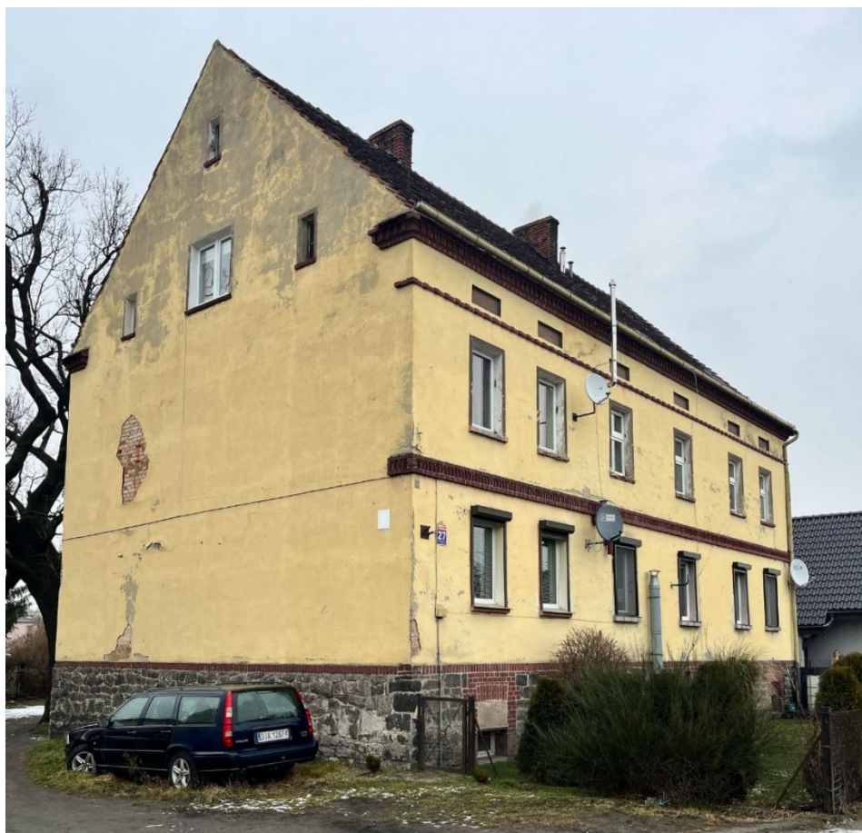
Zdjęcie nr 1 Elewacja południowa i zachodnia
