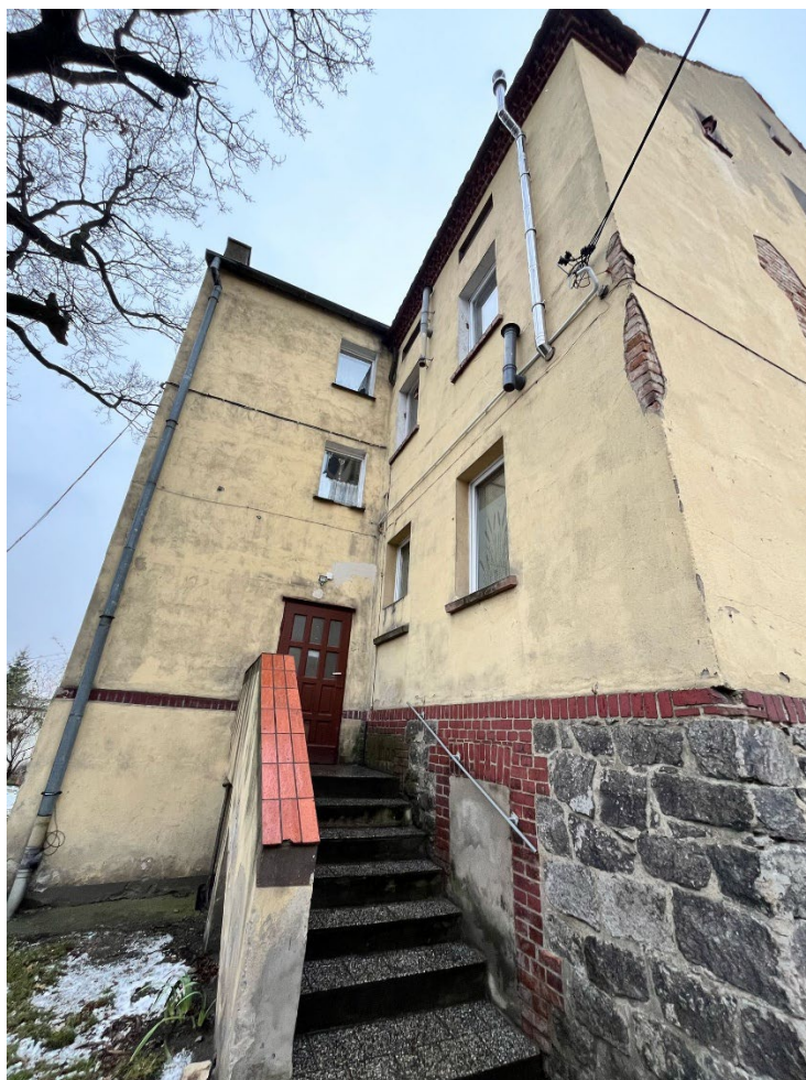
Zdjęcie nr 3 Elewacja zachodnia bocznej bryły – strefa wejściowa
