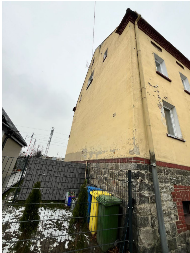
Zdjęcie nr 5 Elewacja wschodnia
