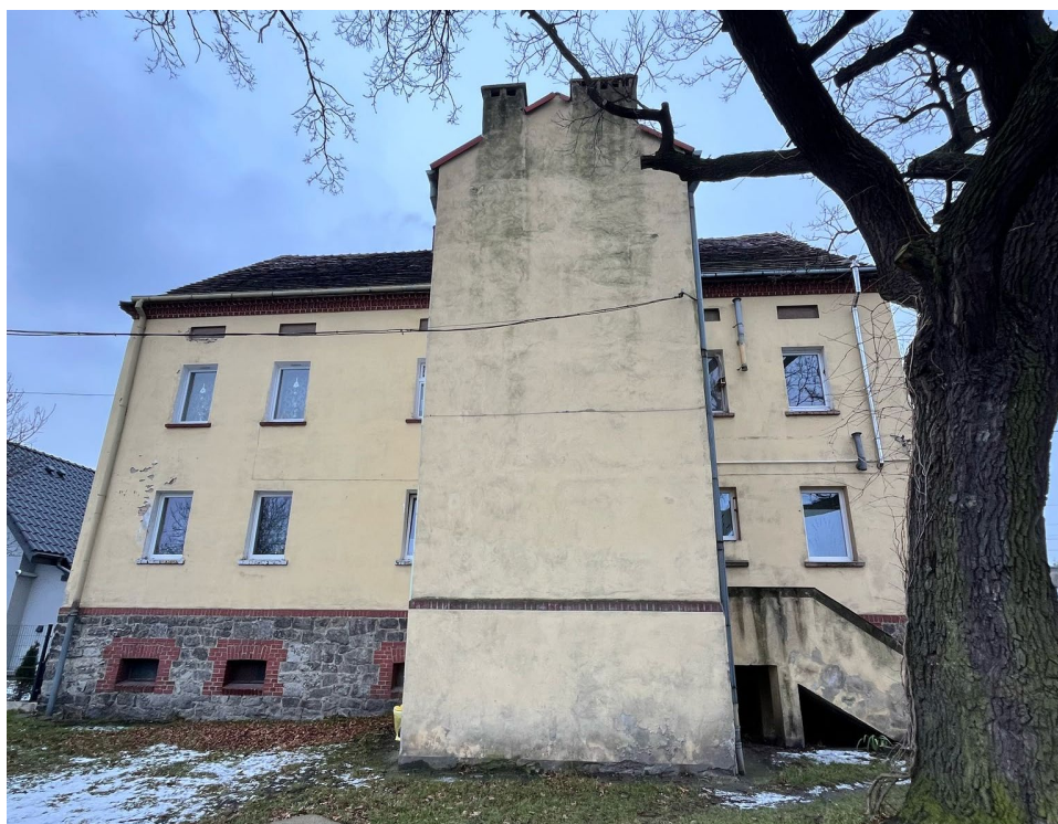
Zdjęcie nr 2 Elewacja północna
