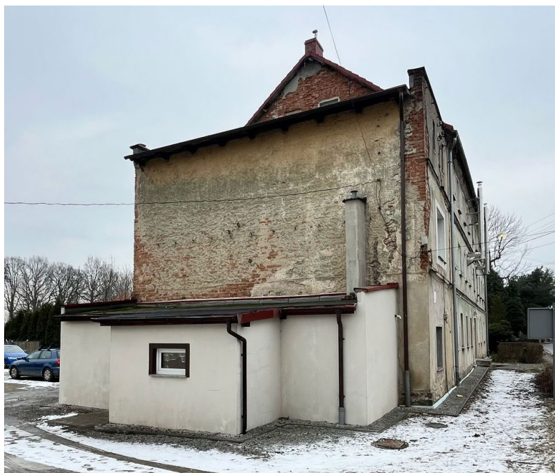
Zdjęcie nr 3 Elewacja północna
