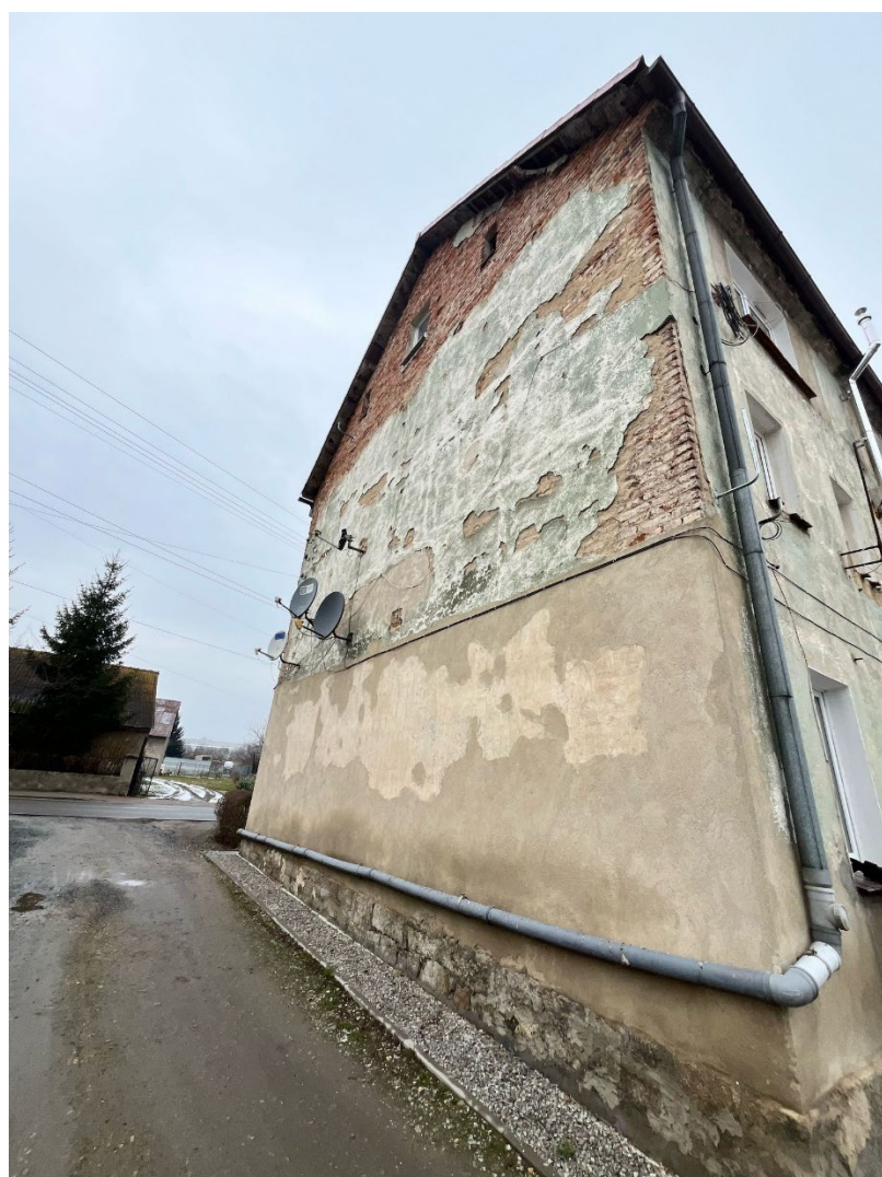
Zdjęcie nr 4 Elewacja południowa
