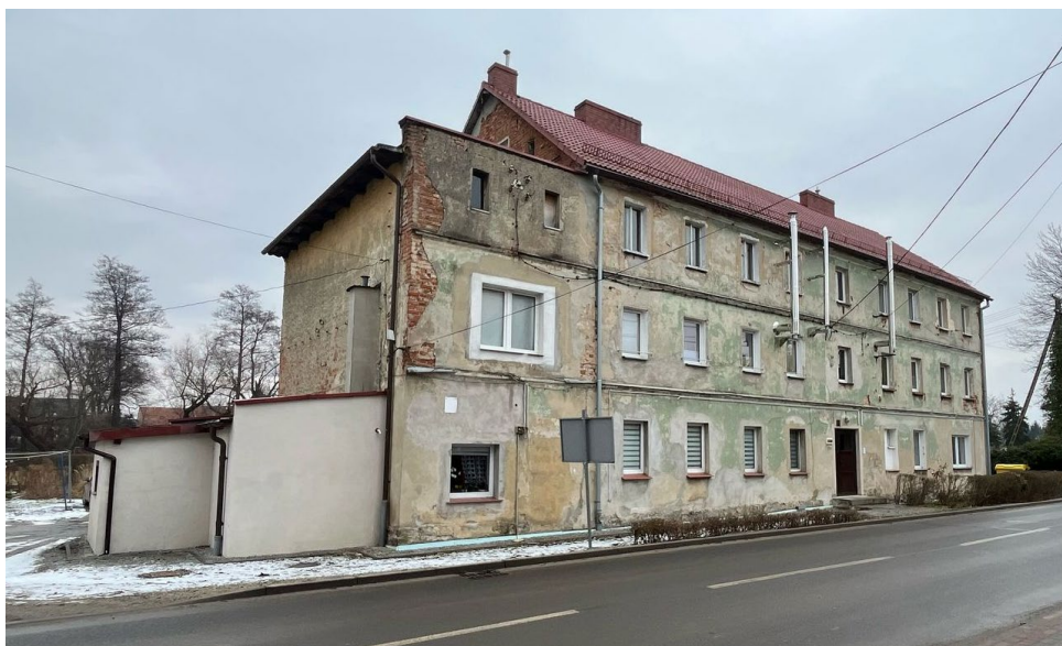
Zdjęcie nr 1 Elewacja zachodnia
