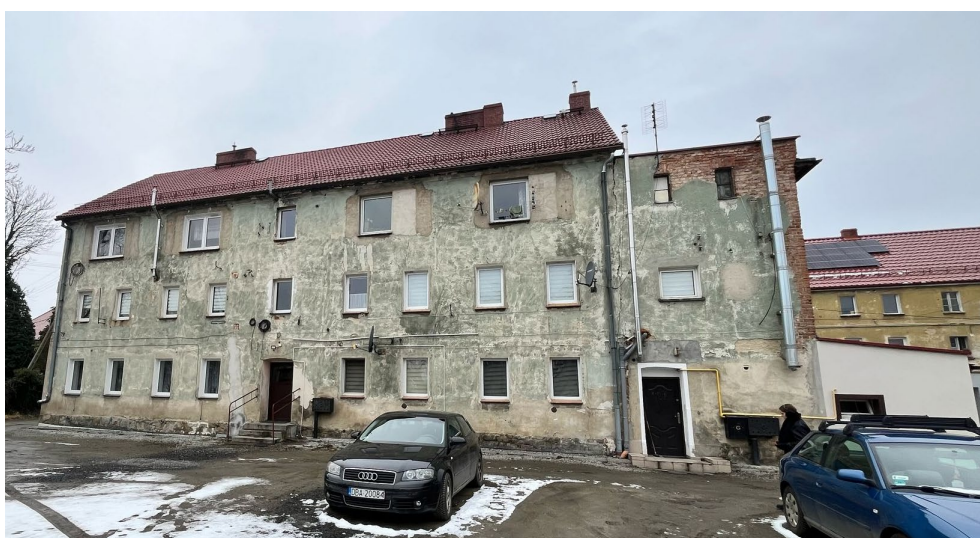
Zdjęcie nr 2 Elewacja wschodnia
