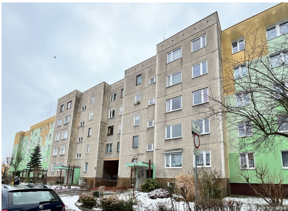
Zdjęcie nr 1 Elewacja północna
