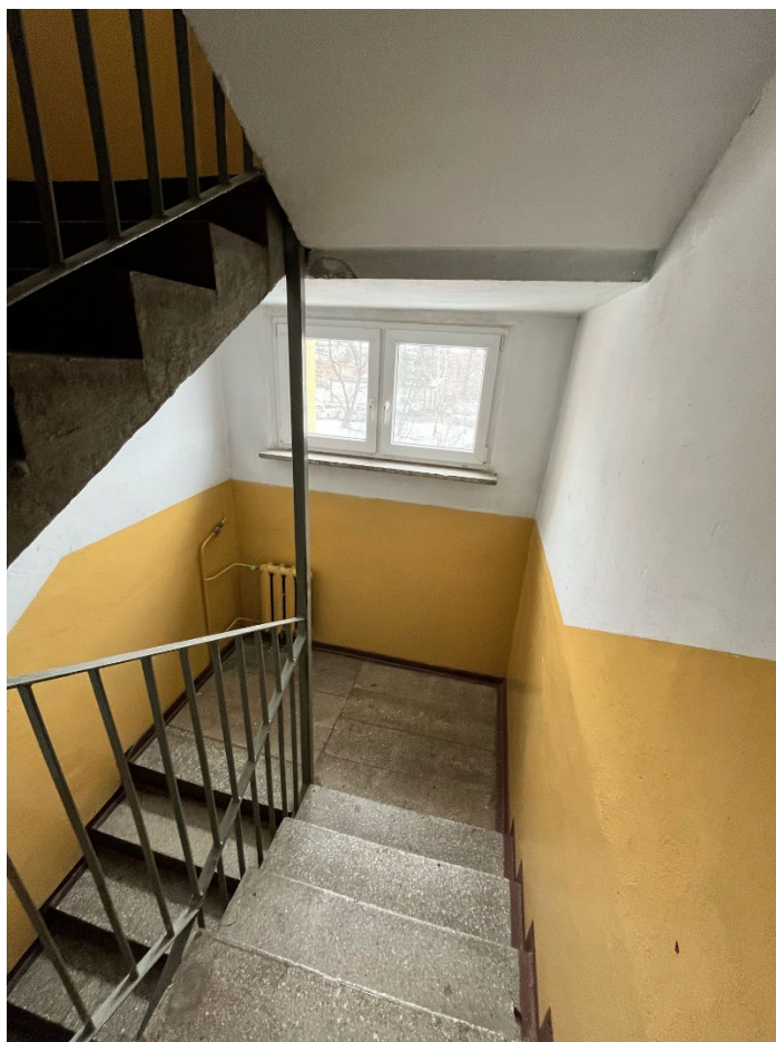
Zdjęcie nr 5 Klatka schodowa - spocznik
