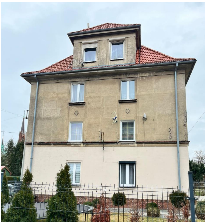
Zdjęcie nr 3 Elewacja północno-zachodnia
