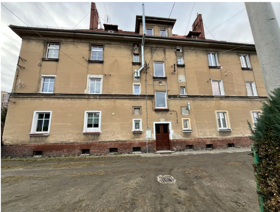
Zdjęcie nr 2 Elewacja północno-wschodnia
