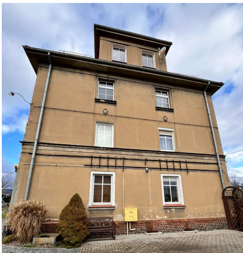
Zdjęcie nr 4 Elewacja południowo-wschodnia
