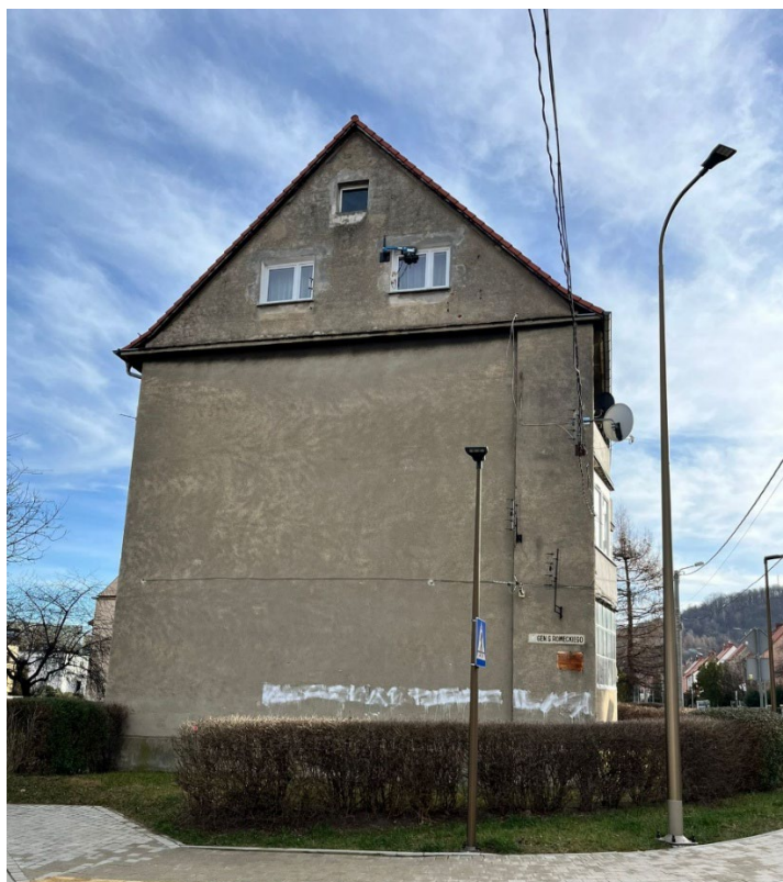
Zdjęcie nr 2 Elewacja północna
