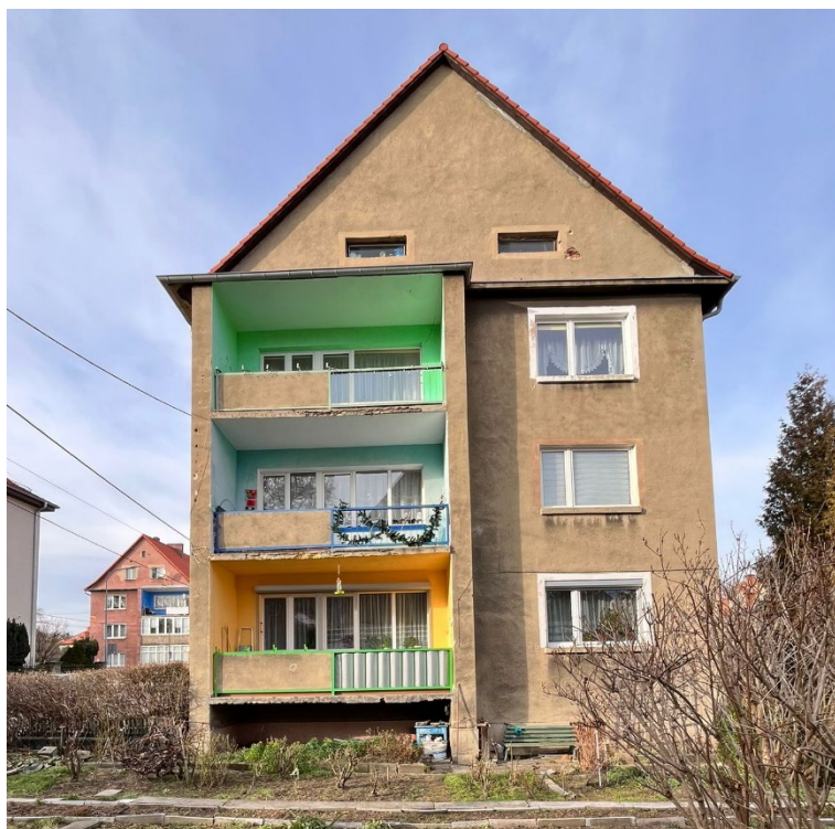
Zdjęcie nr 4 Elewacja południowa
