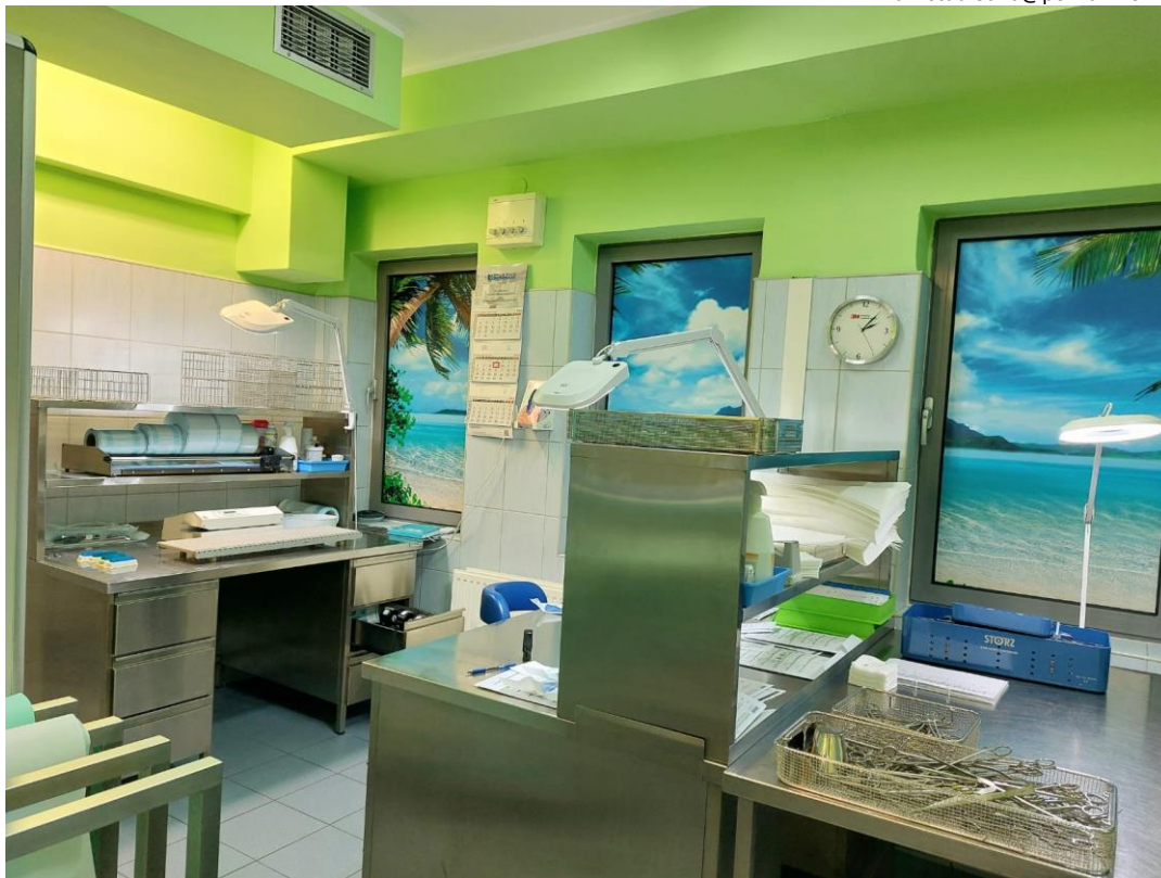
Fot. 4 Pomieszczenie objęte opracowaniem – stan istniejący
