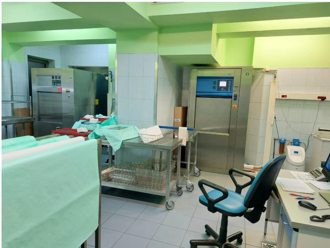
Fot. 3 Pomieszczenie objęte opracowaniem – stan istniejący
