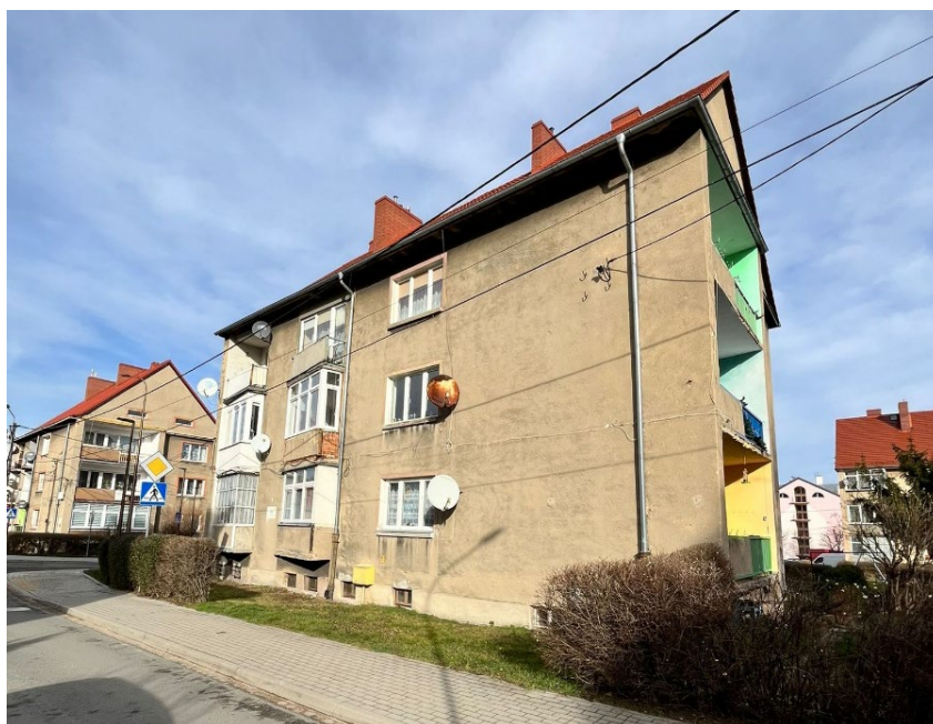
Zdjęcie nr 1 Elewacja zachodnia
