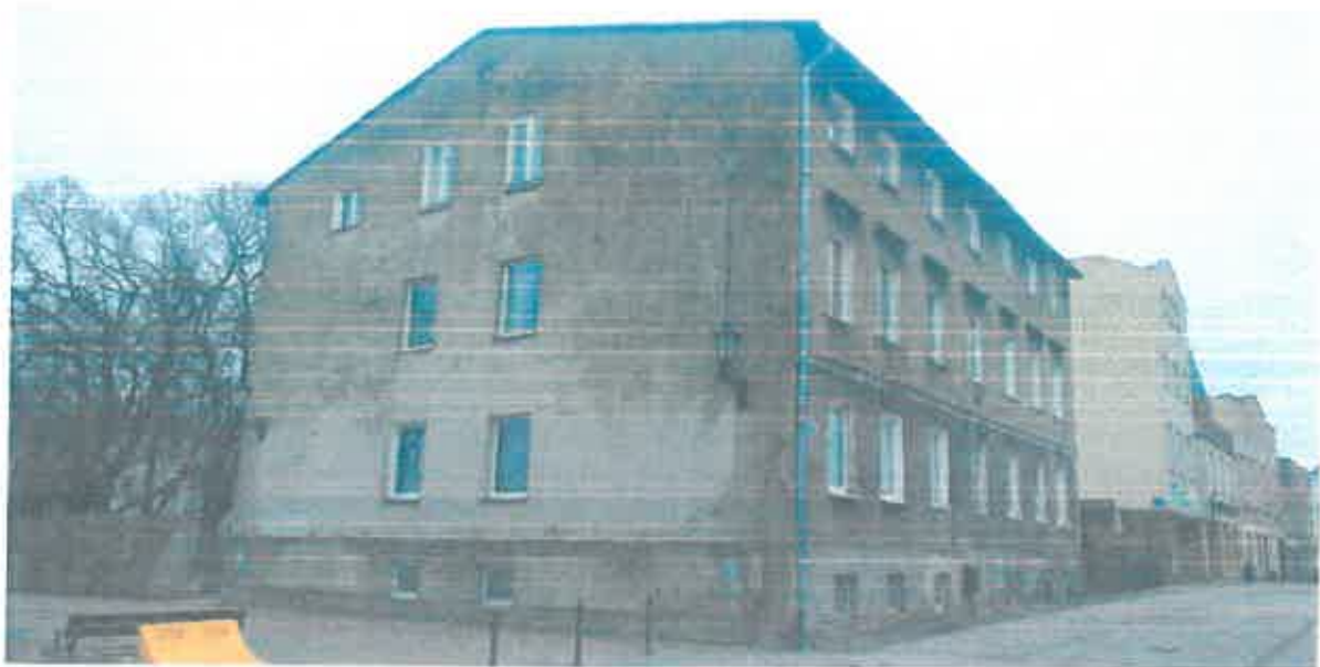
Zdjęcie 2 Naroże budynku usytuowane przy ul. Wałowej i Północnej; widoczna elewacja frontowa biegnąca wzdłuż ul. Wałowej i elewacja szczytowa - wzdłuż ul. Północnej.
