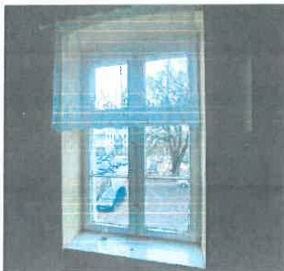
Zdjęcie 6 Oryginalne okno krosnowe dwurzędowe, dwudzielne i powyżej – jednorzędowe, dwudzielne; widoczny detale słupka przechodzącego.
