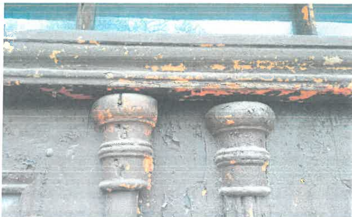
Zdjęcie 10 Detal zachowanych oryginalnych drzwi wejściowych; widoczne główki listew oraz powyżej profilowane siemnię.
