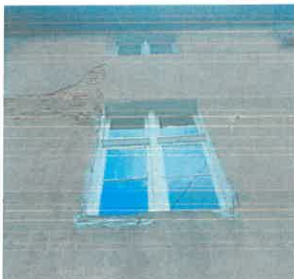
Zdjęcie 6 Oryginalne okno krosnowe dwurzędowe, dwudzielne i powyżej – jednorzędowe, dwudzielne; widoczny detale słupka przechodzącego.
