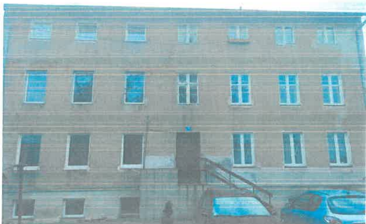
Zdjęcie 4 Elewacja od strony podwórza; siedmioosiowa, pozbawiona wystroju, zachowana oryginalna drewniana stolarka: drzwi wejściowe, okno krosnowe klatki schodowej dwudzielne, dwurzędowe, cztery okna lokali mieszkalnych.
