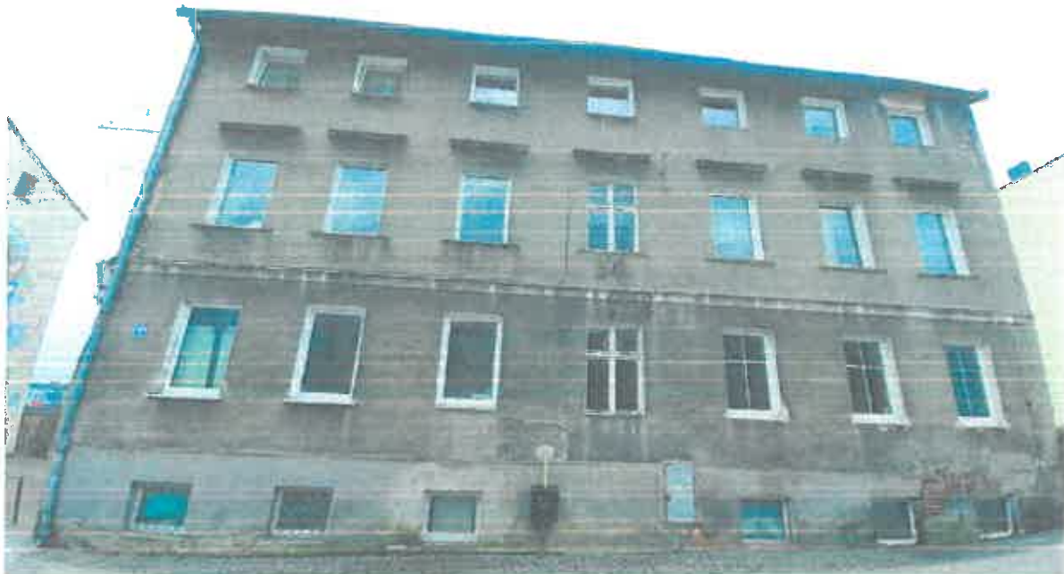
Zdjęcie 3 Elewacja frontowa biegnąca wzdłuż ul. Wałowej; siedmioosiowa, wtórna stolarka okienna, pozbawiona wystroju architektonicznego, zachowany detal elewacji to linie gzymsów.
