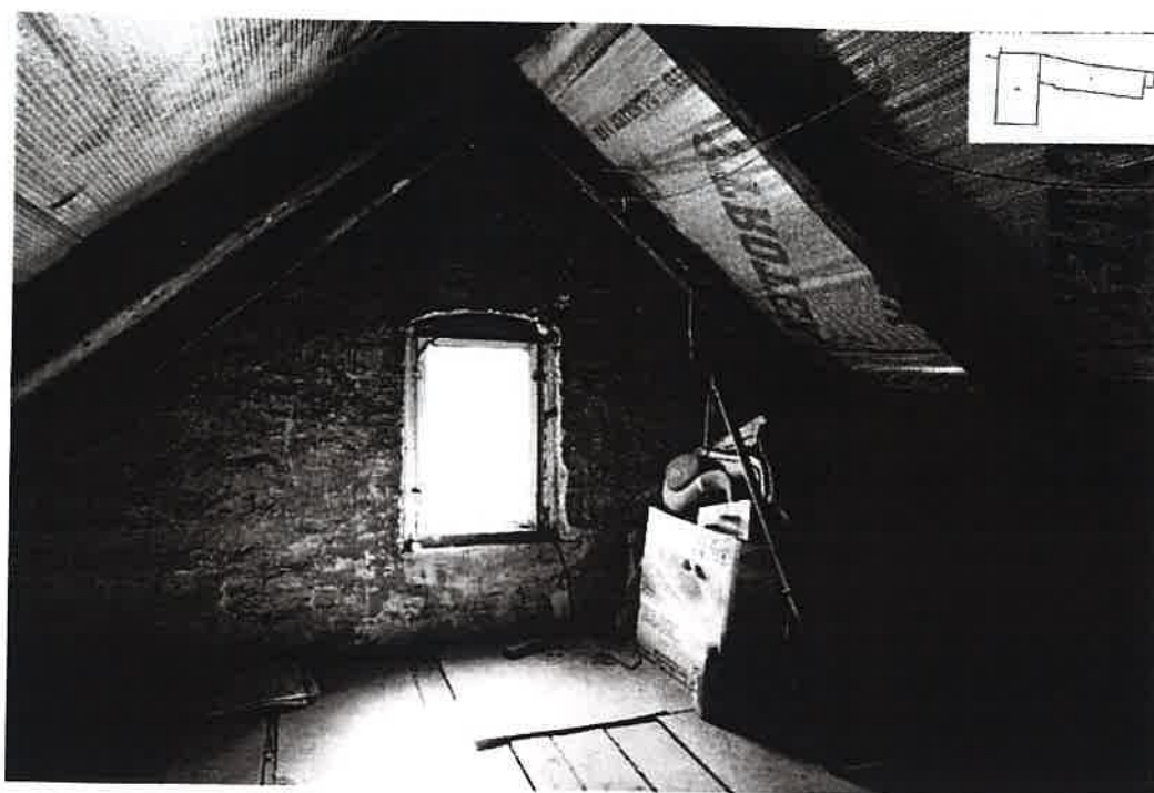
Fot. 7. Strych budynku przy ul. Bohaterów Getta 12 w Głuszyca.
