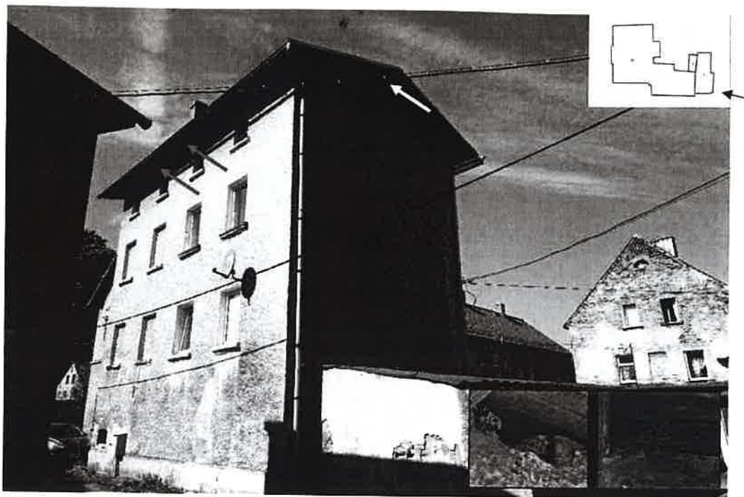
Fot. 5. Elewacja boczna i tylna budynku przy ul. Bohaterów Getta 12 w Głuszycy. Strzałką niebieską zaznaczono szczelinę, która nie była wykorzystywana przez ptaki, a która może zostać przez nie zajęta w kolejnych sezonach lęgowych. Strzałką zieloną zaznaczono miejsce gniazdowania jerzyka. Strzałką białą zaznaczono lokalizację gniazda gołębia miejskiego.
