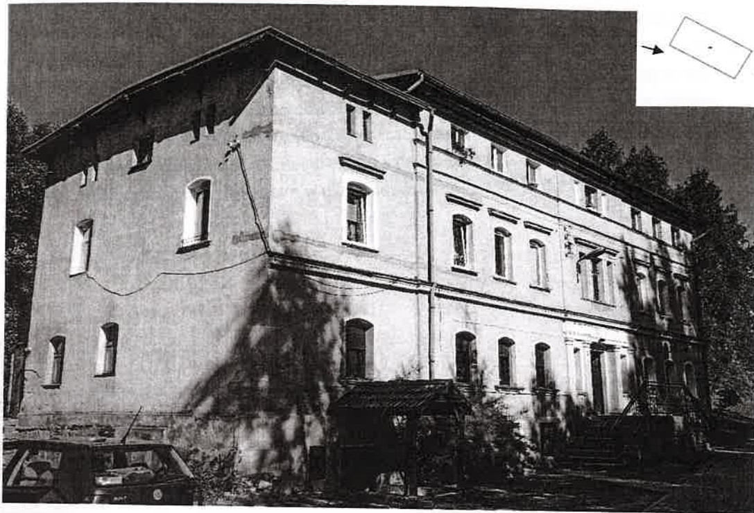
Fot. 1. Elewacja boczna i frontowa budynku przy ul. Kościuszki 3 w Głuszycy.
