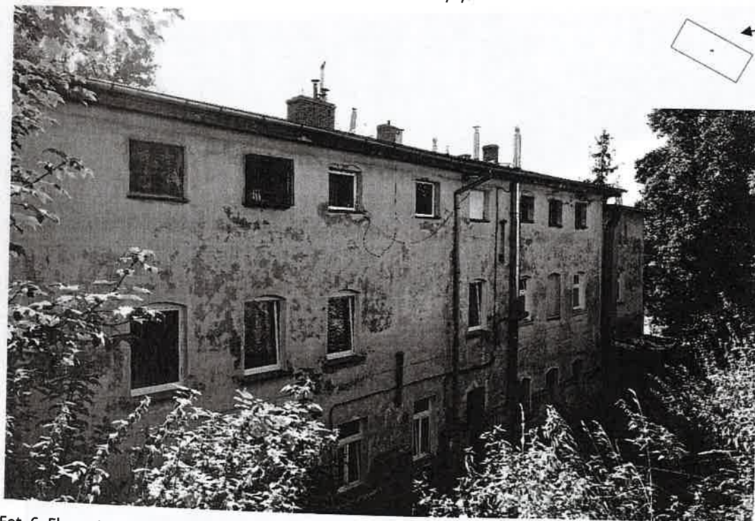
Fot. 6. Elewacja tylna budynku przy ul. przy ul. Kościuszki 3 w Głuszycy.
