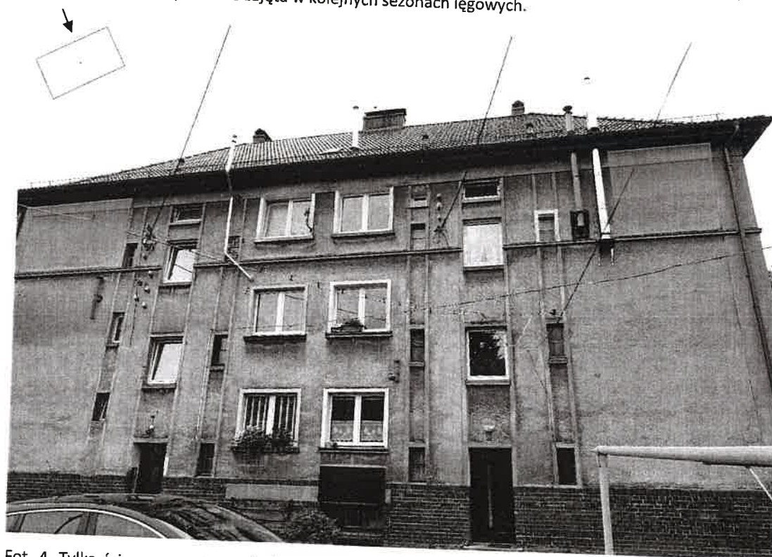
Fot. 4. Tylka ściana przy ul. Częstochowskiej 4 w Głuszcy. Na zielono zaznaczono obszary, w obrębie których zaleca się zamontować budki dla wróbla i jerzyka.
