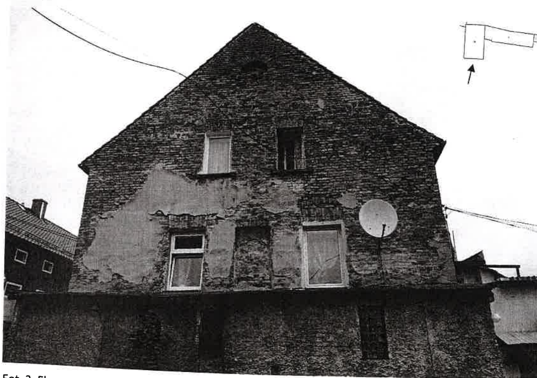
Fot. 2. Elewacja boczna budynku przy ul. Bohaterów Getta 14 w Głuszycy.
