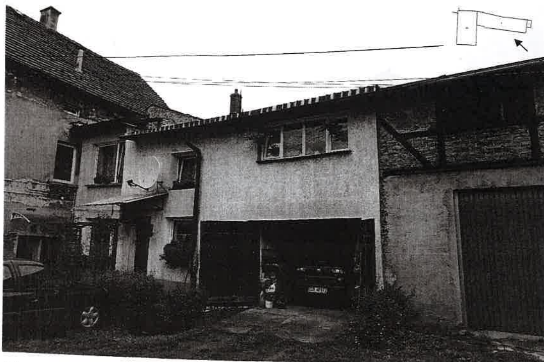
Fot. 4. Elewacja boczna budynku przy ul. Bohaterów Getta 14 w Głuszycy.
