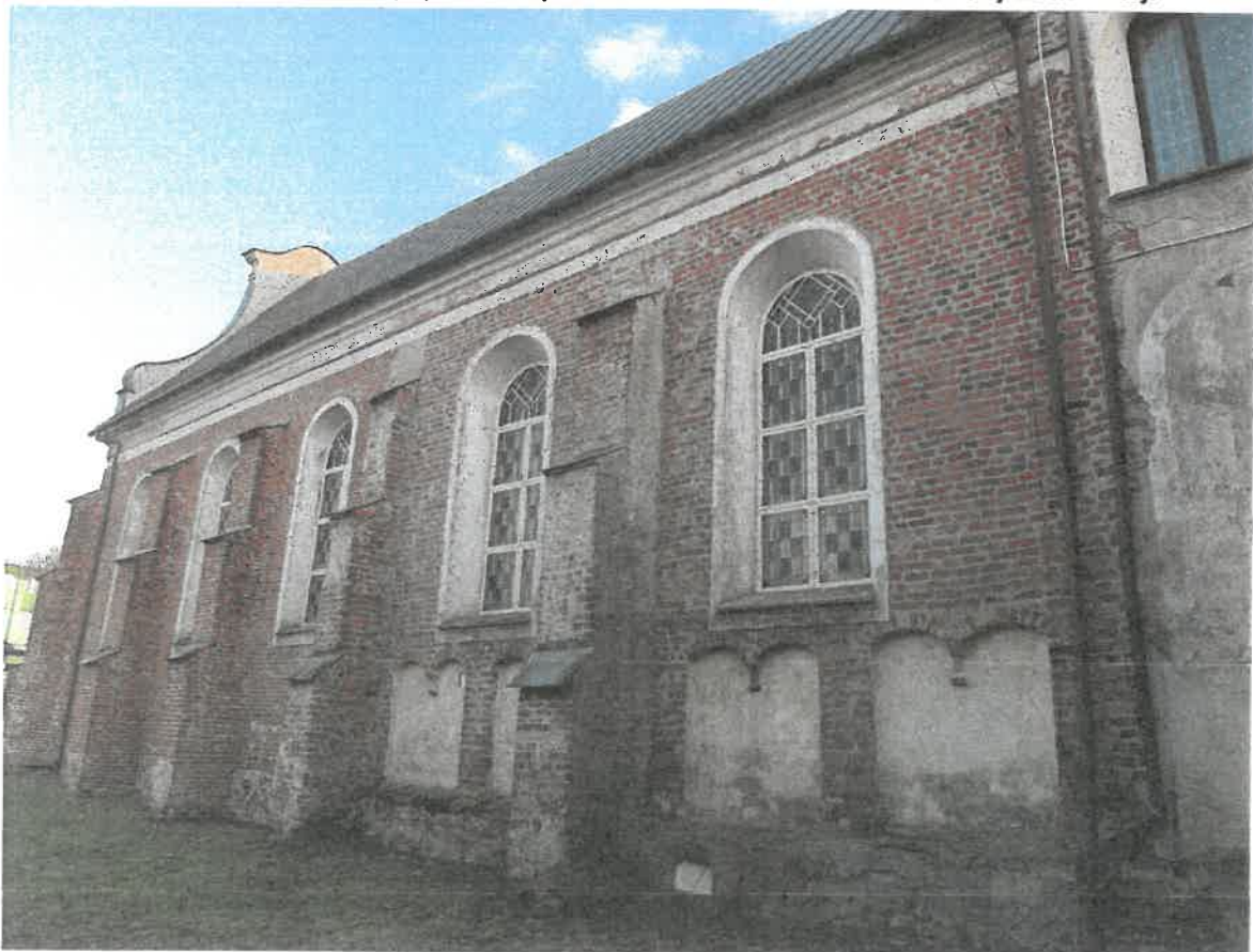
2. Elewacja północna prezbiterium kościoła. Widok od strony zachodniej.
