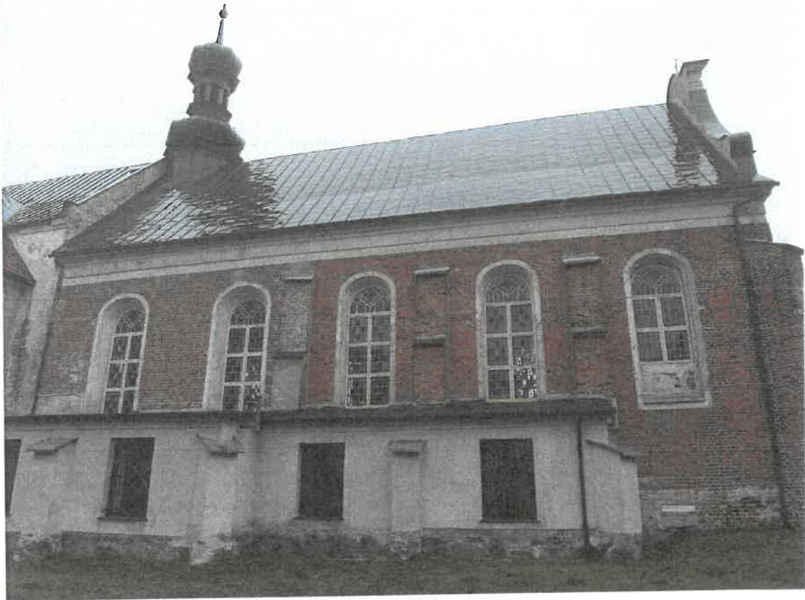
5. Elewacja południowa prezbiterium kościoła.
