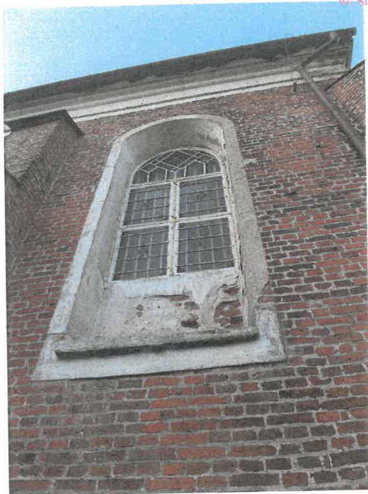
7. Otwory okienne w oprawach tynkowych (kamiennych?).
