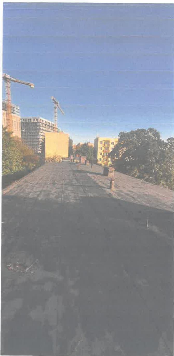
Widok dachu w kierunku północnym.
