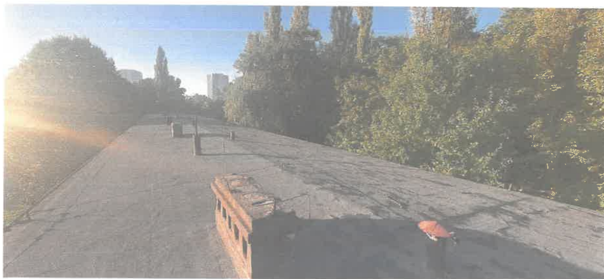
Widok dachu budynku w kierunku południowym.
