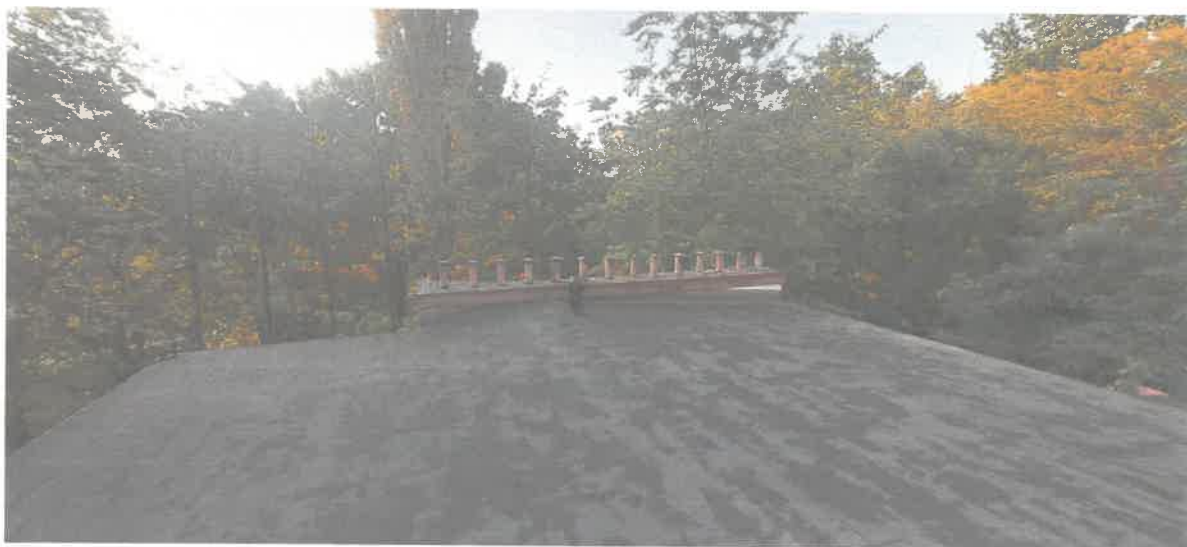
Widok komina wentylacyjnego w ścianie południowej.
