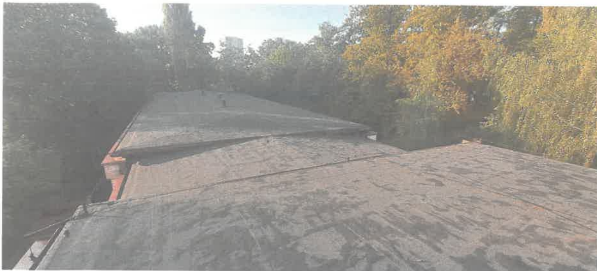
Widok dachu budynku w kierunku południowym.
