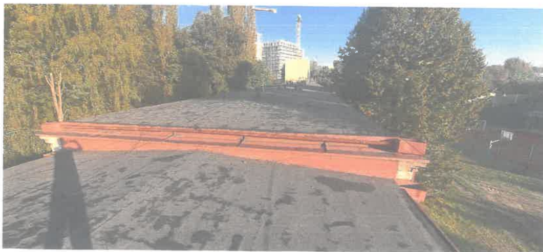
Widok dachu nad strefą wejściową budynku.
