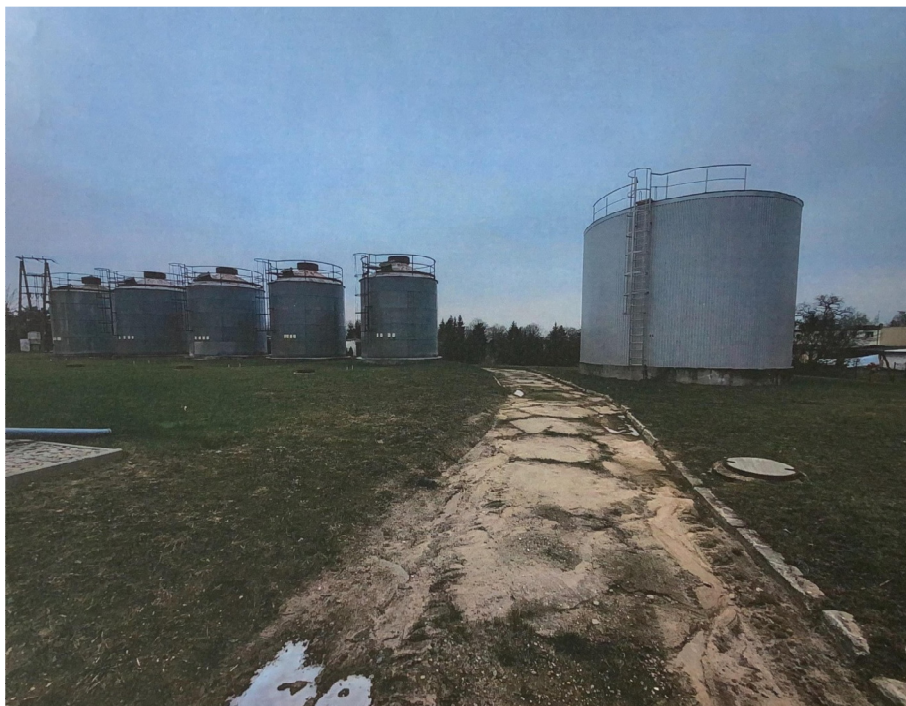
Rys.3.2 Zdjęcie istniejących zbiorników retencyjnych na SUW w Szreniawie.
