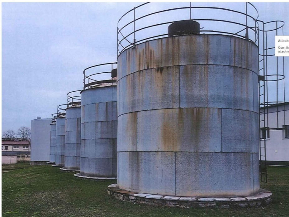
Rys.7.2 Widok istniejących zbiorników stalowych.
