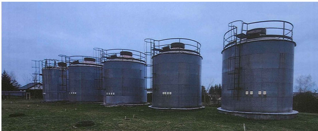
Rys.7.1 Widok istniejących zbiorników stalowych.
