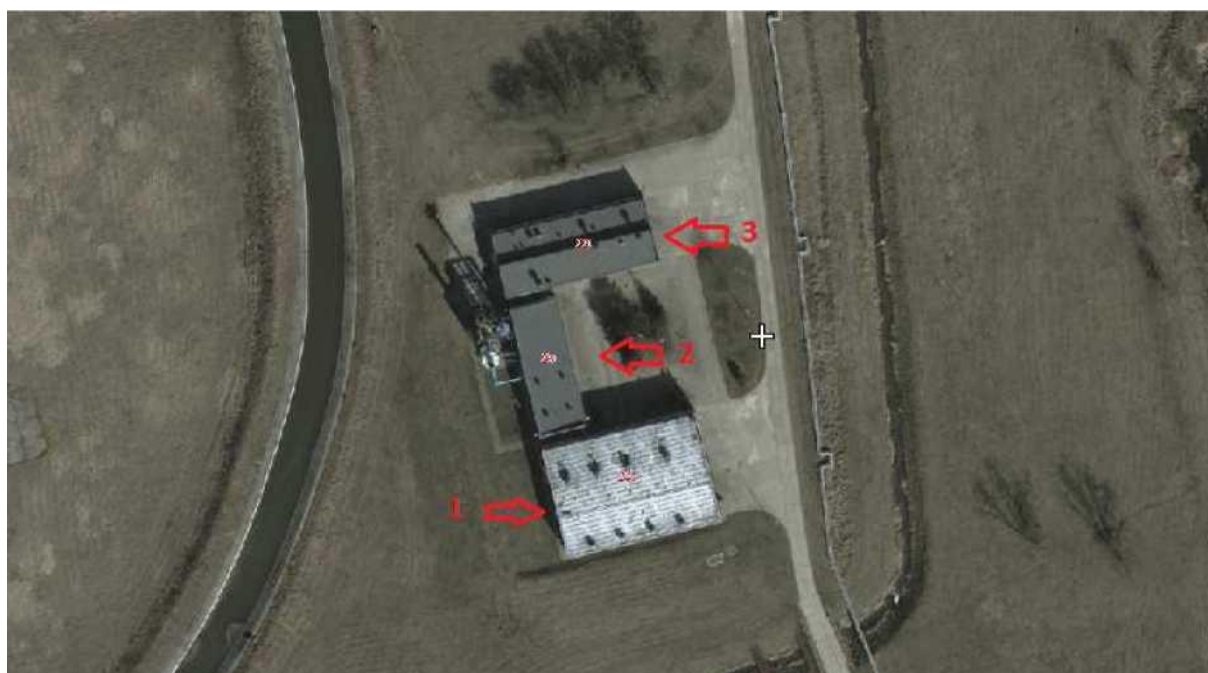
Rys. 1. Istniejące budynki chlorowni w ZPW Legnica
