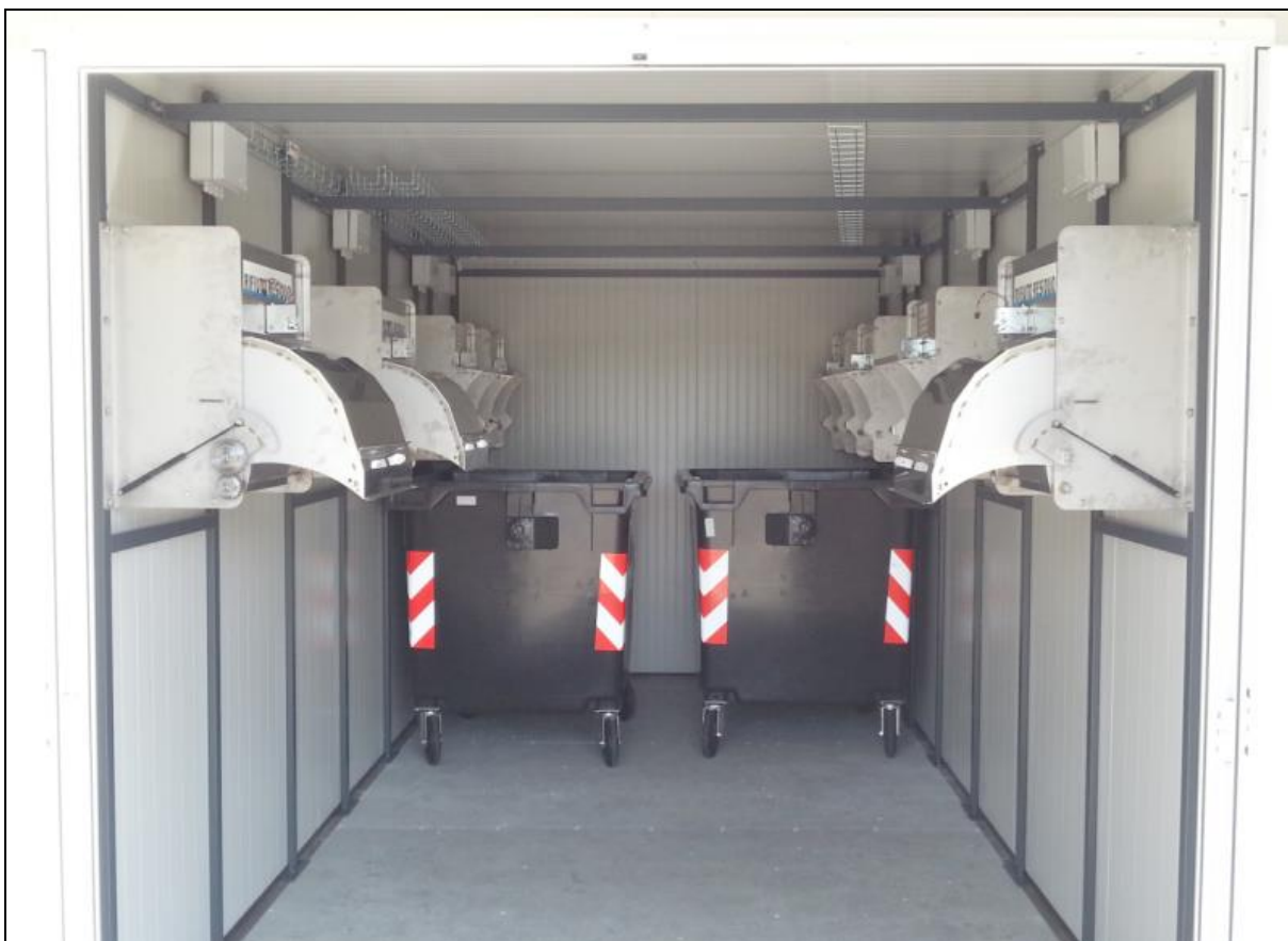
Ryc. 15. Wnętrze zbiornicy – wrzutnie i przykładowe pojemniki na odpady
